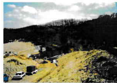
〔宇津貫緑地調整池の工事〕
